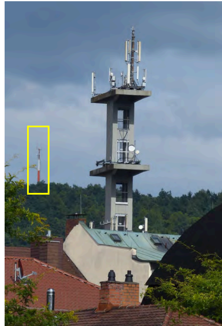
Mobilfunksendeanlage Nr. 660012, Nähe Theaterplatz (Höhe 30- 48 m) und TETRA- Sender auf östl. Anhöhe 09.11.09: 21 Sektorantennen 18.04.16: 27 Sektorantennen 11.09.18: 33 Sektorantennen
