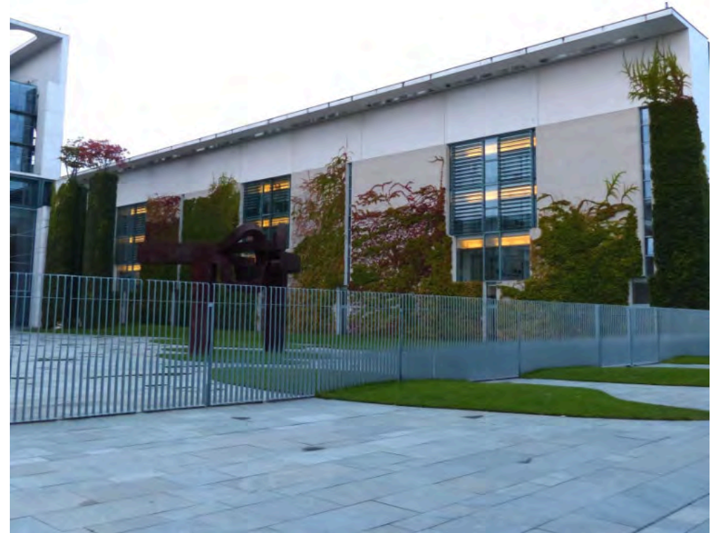
15.09.17 Bundeskanzleramt, Südseite des Nordflügels
