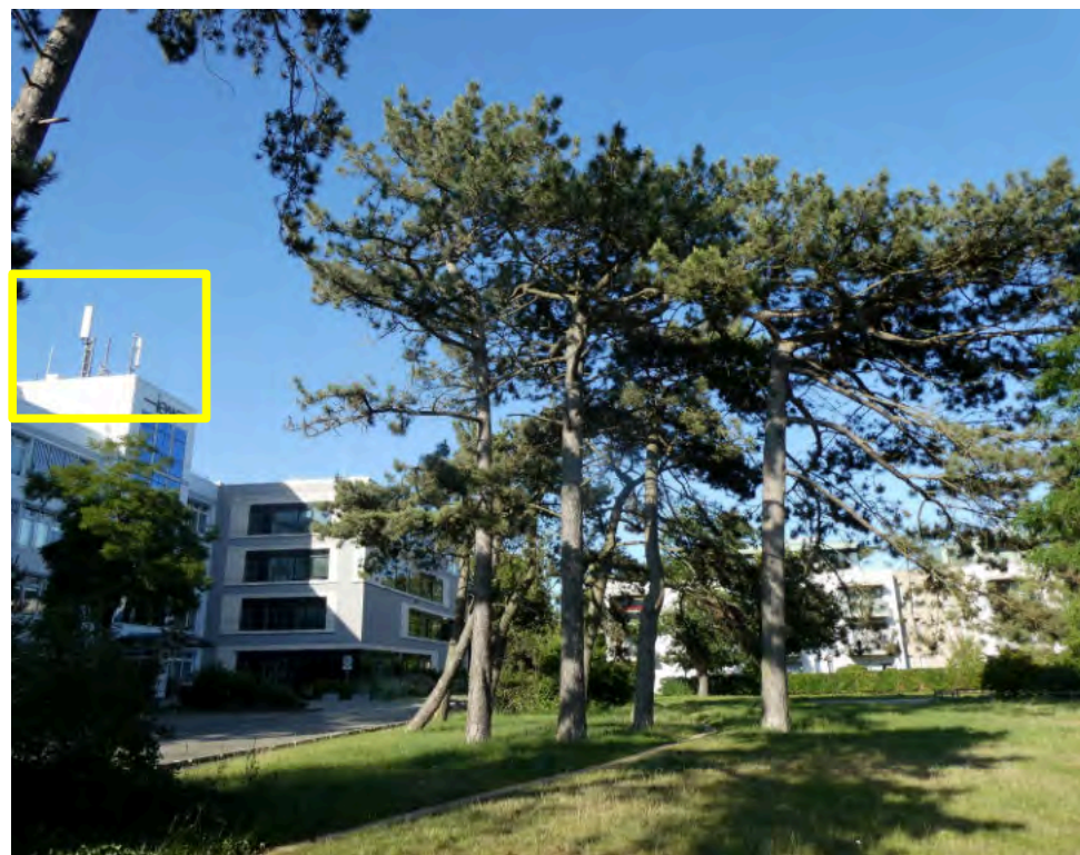
20.06.25 Kurpark, Kieferngruppe (von SW), Mobilfunksendeanlage auf dem Institut für Ostseeforschung, Standortbescheinigung vom 03.08.22: Montagehöhe 21,7- 23 m, 18 Mobilfunksektorantennen (6 x 0°, 6 x 120°, 6 x 240°).
