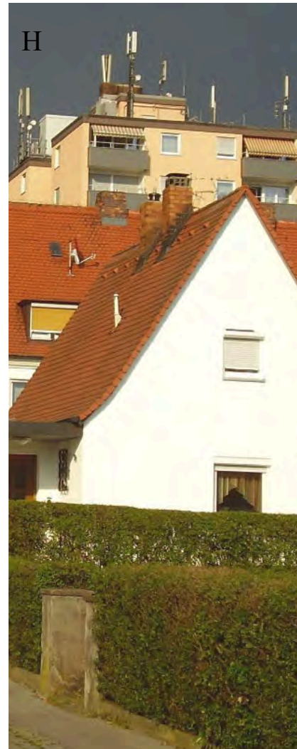
Sendeanlage Hauptsmoorstr. 26 a
