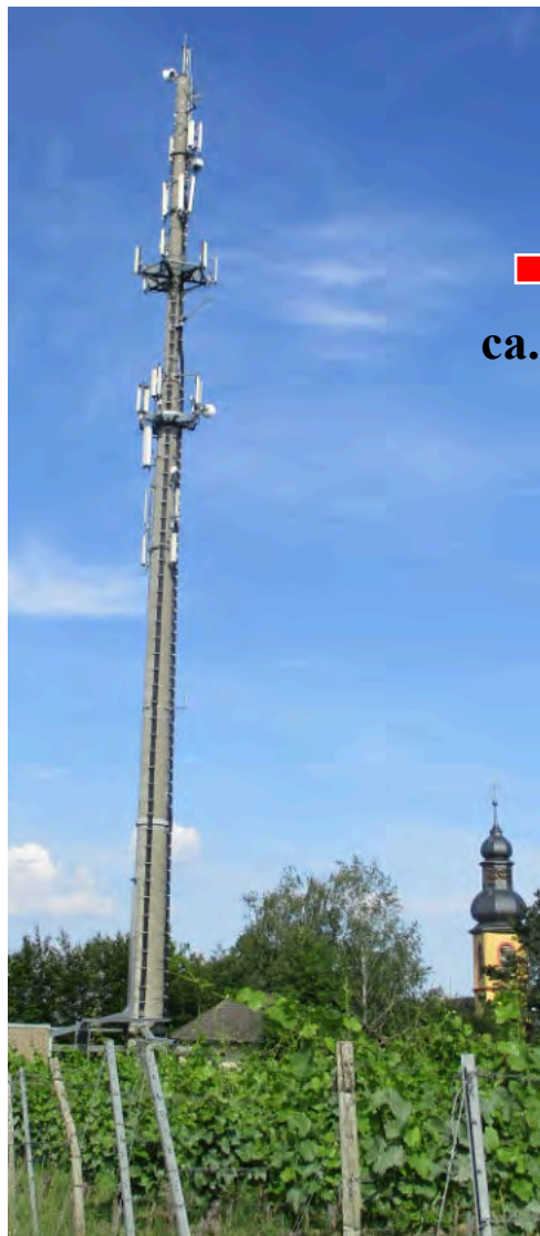
03.07.21 Sendemast über Nackenheim Höhe: 22,9 - 43,6 m, 33 Sektorantennen, 2 Sonstige Funkanlagen
