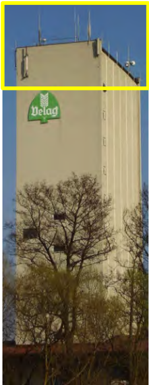
30.04.07 Sulzdorf, Sendeanlage Nr. 770395
