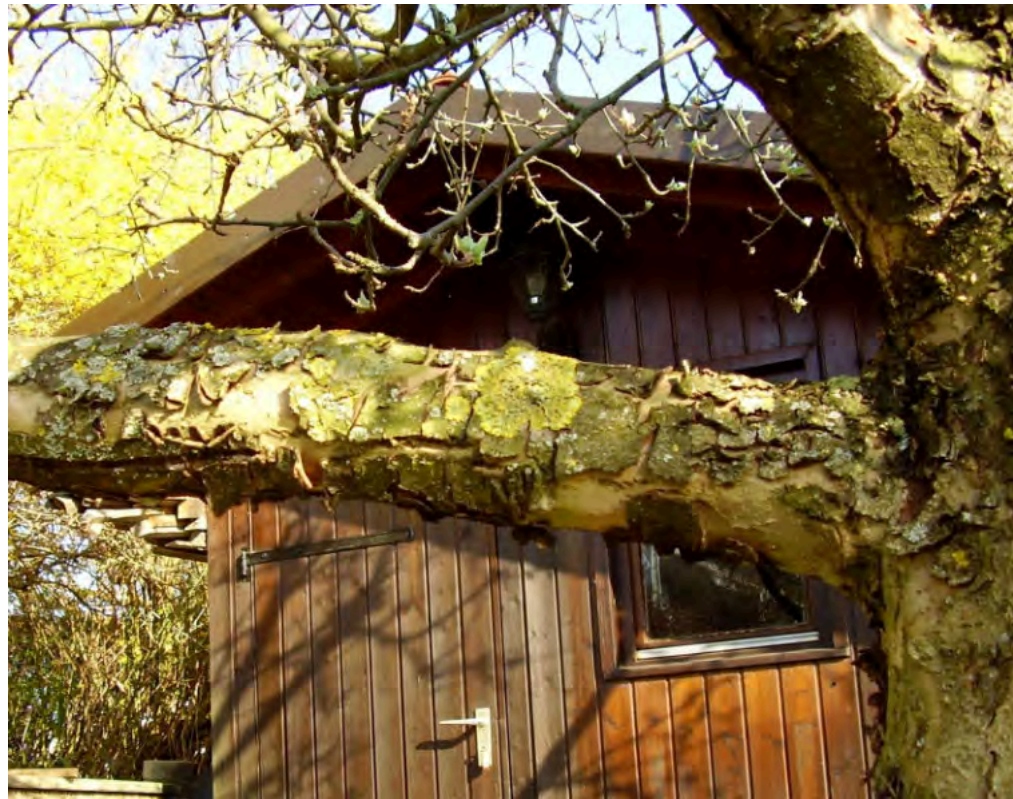
30.04.07 Sulzdorf, Im Rohr. Die Entfernung zur Sendeanlage betrug ca. 450 m. An allen Obstbäumen dieses Gartens waren Risse und Abblättern der Borke aufgetreten. Flechten hatten sich verbreitet.
