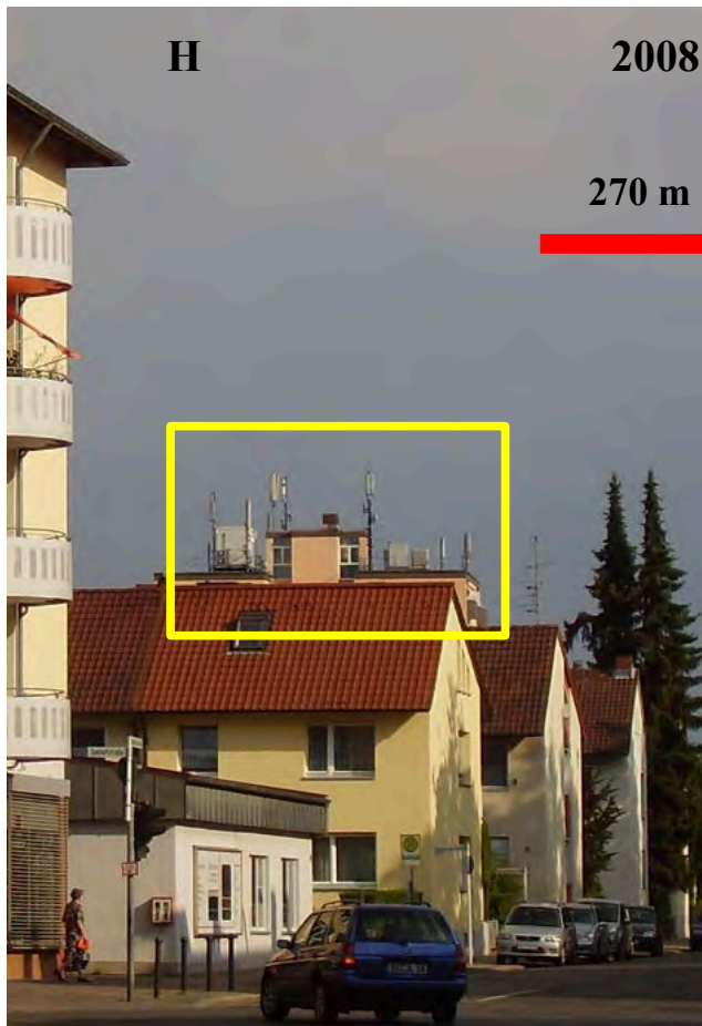
Mobilfunksendeanlage Hauptsmoorstr. 26 a, Höhe: 26,6 m – 31,1 m, 18 Antennen
