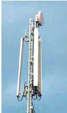
Typische Mobilfunkbasisstation mit drei Sektorantennen und Richtfunk.
