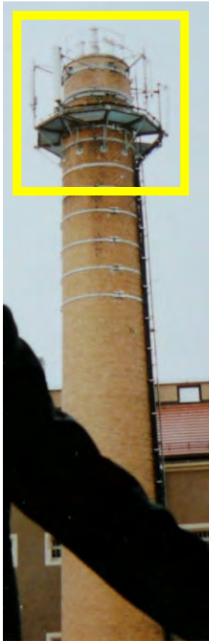
Mobilfunksendeanlage an dem Kamin des Gerichtsgebäudes
