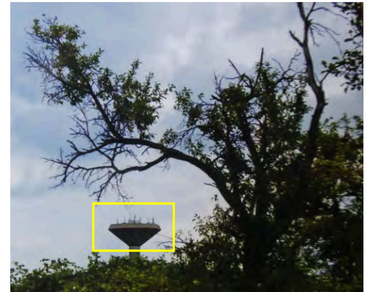
10.07.07 Uttenhofen, Wasserturm mit Sendeanlage, geschädigter Obstbaum (von S).
