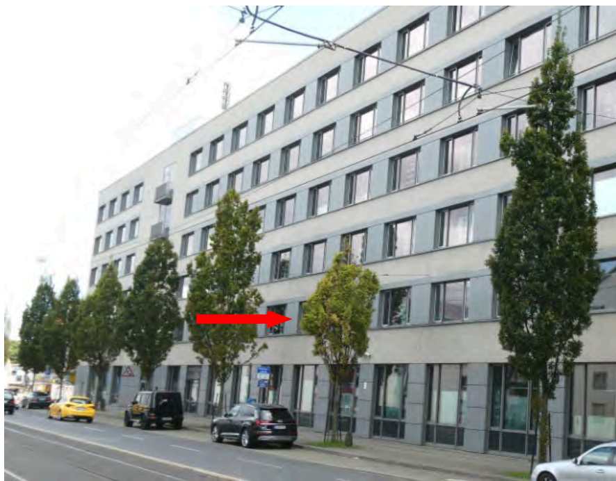
9 8 7 6 5 4 3 21.08.25 Weserstraße, Säuleneichen Nr. 3 bis Nr. 9 (von W). Säuleneiche Nr. 4 ist deutlich kleiner und hat gelbe Blätter.
