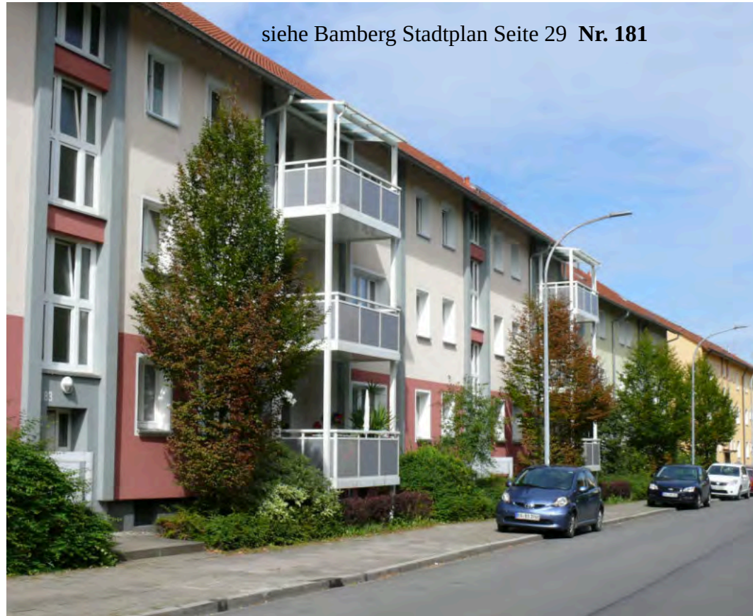
25.08.14 Hauptmoorstr. 83 bis 89, Hainbuchenreihe ( von SO ). Von Süden treffen die Hochfrequenz-Immissionen auf die Hainbuchen. Die beiden nördlichen Hainbuchen (Nr. 87 und Nr. 89) werden durch die südlich stehenden (Nr. 83 und Nr. 85) von der Strahlung teilweise abgeschirmt. Sie sind grün belaubt. Die Entfernung zur Sendeanlage beträgt 430 bis 480 m.
