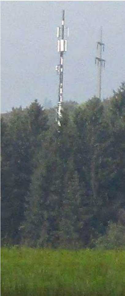
Mobilfunksender Rickenbach Blick von Süden, vom Waldrand
