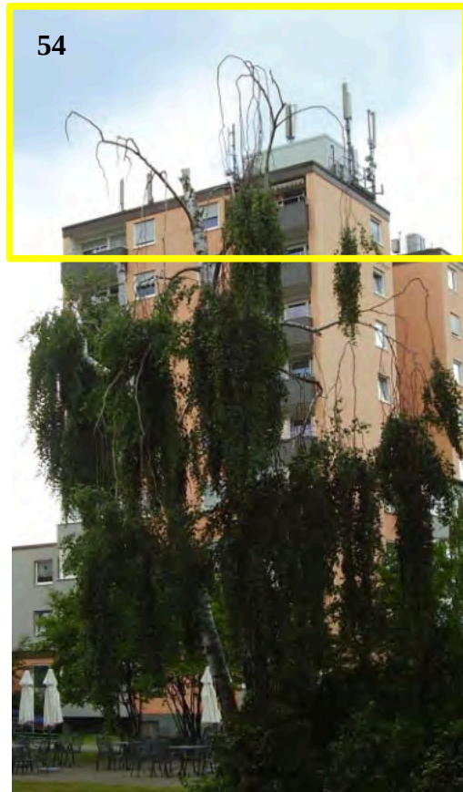
08.07.08 Sendeanlage Hauptsmoorstr. 26 a, Innenhof, Birke (von NO)
