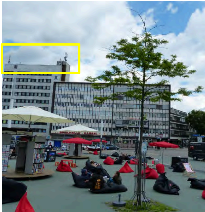
31.05.19 Kassel, Hauptbahnhof, Gleditschie (von W). Es besteht Sichtverbindung zu weiteren Sendeanlagen.
